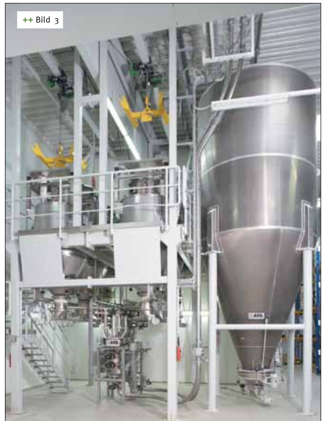
++ Bild 3 Zutatenstation zum Wiegen der Klein- und Mittelkomponenten, rechts daneben Innensilo für Salz
