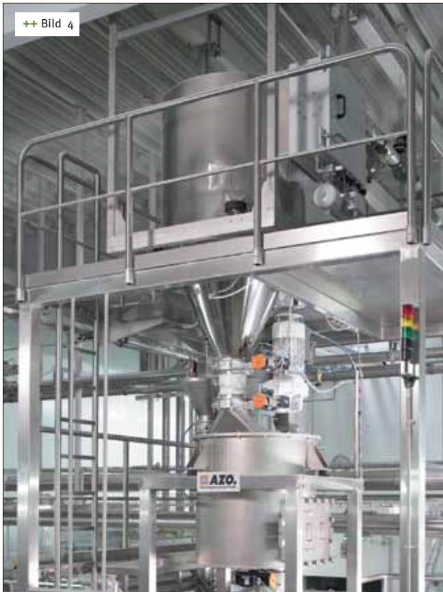
++ Bild 4 Förderwaage zur Beschickung der Knetelinien
