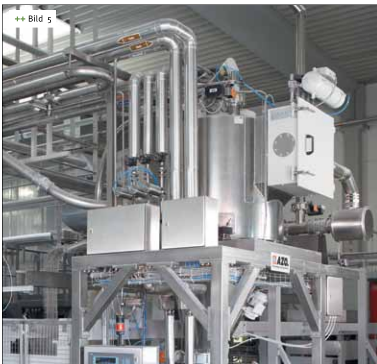
++ Bild 5 Saugwiegesysteme mit Förderwaagen zur Beschickung verschiedener Prozesslinien
