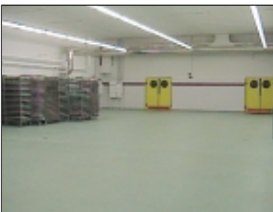
Der Fußboden in der Kommissionierhalle ist 5 Jahre alt und sieht immer noch aus wie neu.
