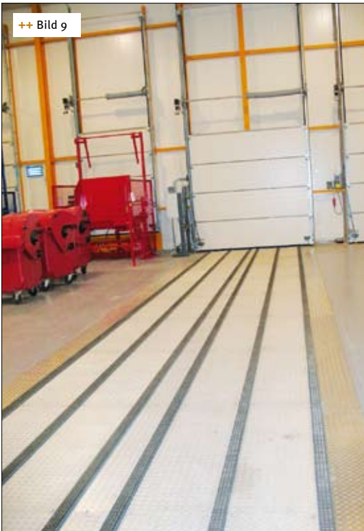
++ Bild 9 Die stählernen Laufbänder schieben die fertig gepackten Paletten auf den Truck, der sie in das Speditionslager bringt
