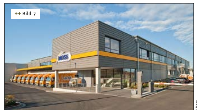
++ Bild 7 Am Neubau in der Kellershaustraße stehen 5.367 m² Produktionsfläche zur Verfügung
