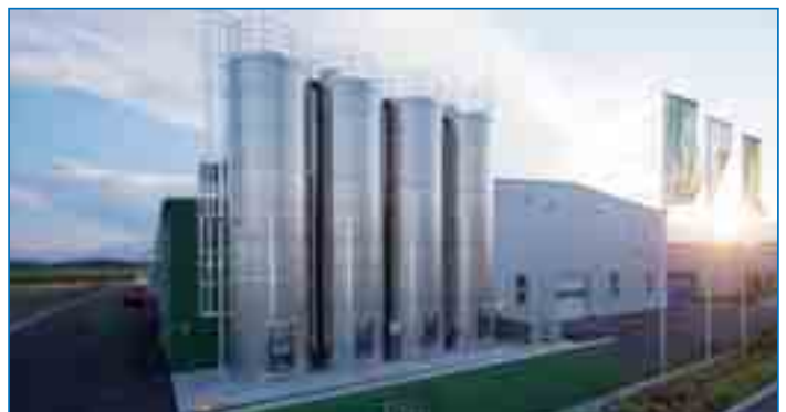
Die Mehl-Silos stehen draußen, während die Mittel- und Kleinkomponentensilos im 1. Stock des Gebäudes untergebracht sind.
