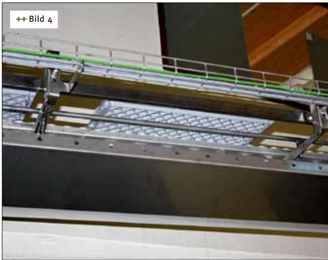
++ Bild 4 Unterhalb des Transportbands für die Körbe auf dem Weg zur Waschanlage liegt eine Auffangwanne, um Krümel und andere Reste der verschmutzten Wanne aufzufangen
