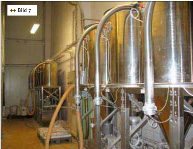
++ Bild 7 Aus Stahltanks werden weitere Rohstoffe per Druckluft zudosiert
