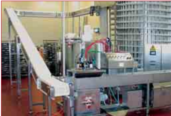
Die komplette Chinois-Anlage samt Trockenstrecke.
