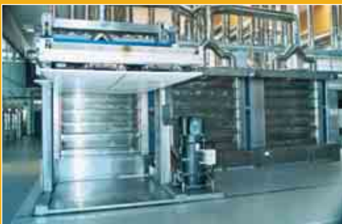
Erstmals setzt man auch Ringrohröfen ein. Die gemauerten Öfen von Hein haben jeweils ein Gewicht von 17 t.
