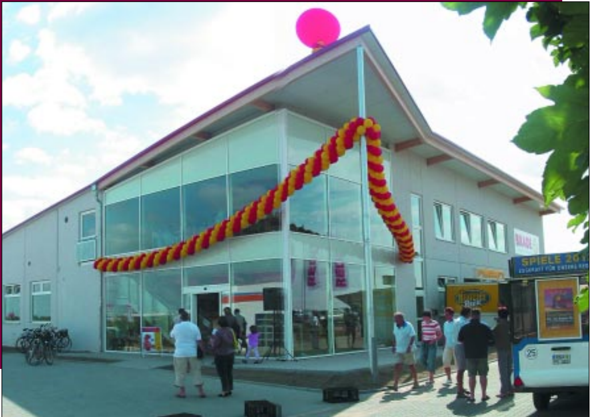
Neubau der Bäckerei Brade in Röderau-Bobersen – mit Factory-Outlet..
