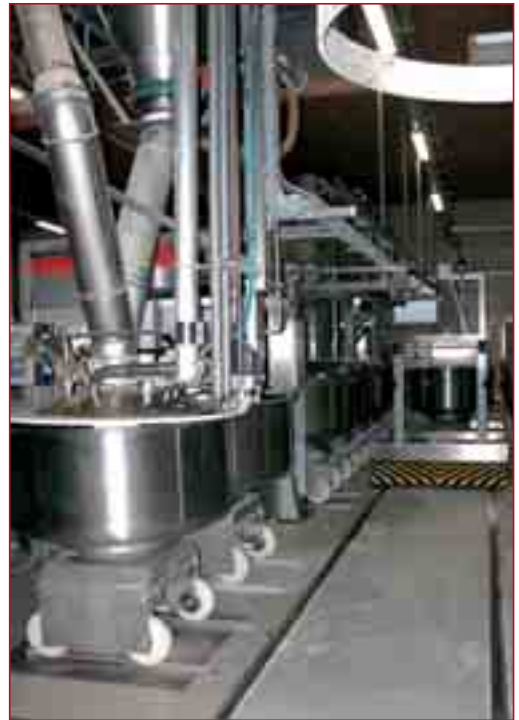
Der Carrier für den Bottichtransport läuft auf Schienen zwischen den Reihen der Ruheplätze. Vorne links die Dosierung, dahinter ein Knetter. Die beiden anderen Knetter stehen rechts.
